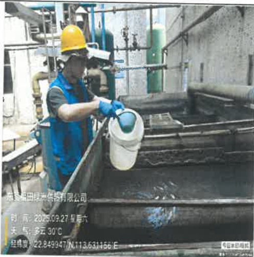
脱硫废水排放口
